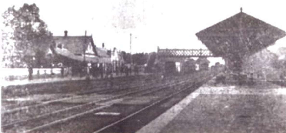
站台、雨棚、天桥
