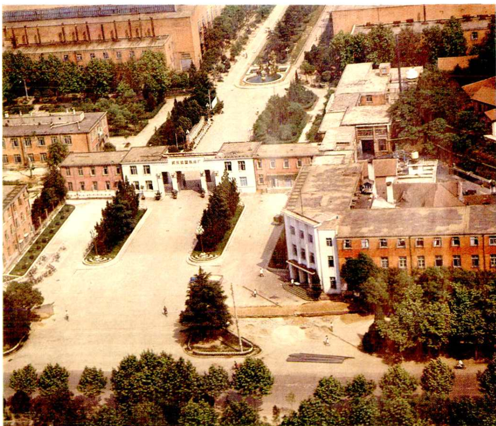
武汉重型机床厂厂区正大门及中央干道
