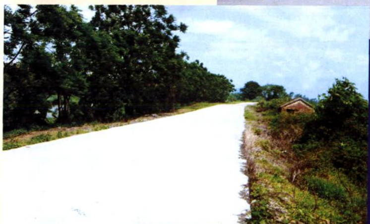
乡村铺设了 水泥道
