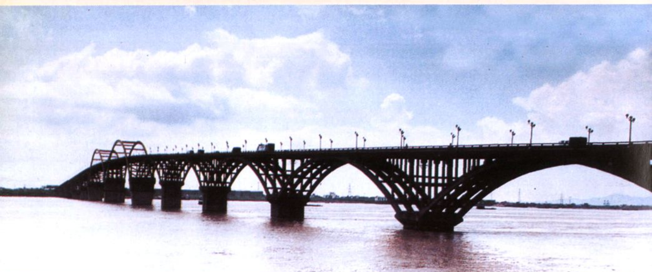
1991年12月建成的高明大桥
