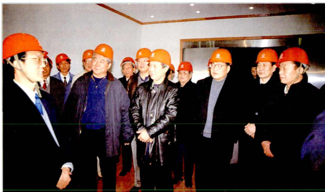
1998年12月31日晚，中共陕西省委书记李建国（前排左三）、省长程安东（前排左二）视察110千伏振兴变电站并慰问节日期间坚守岗位 的西安供电职工
