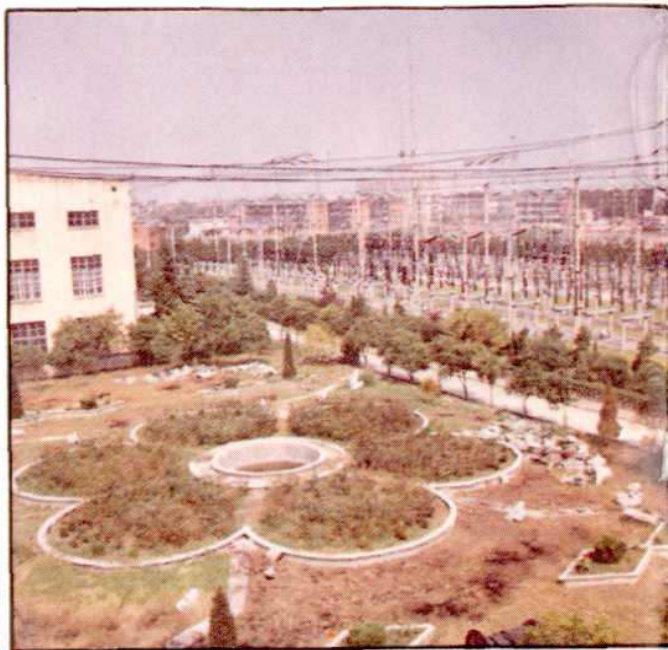
220千伏螺丝岗变电所
