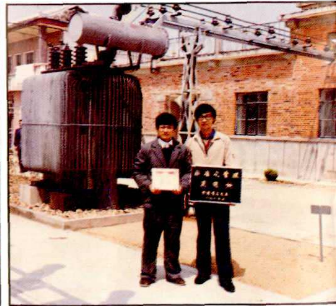
35千伏白龙标准化变电所
