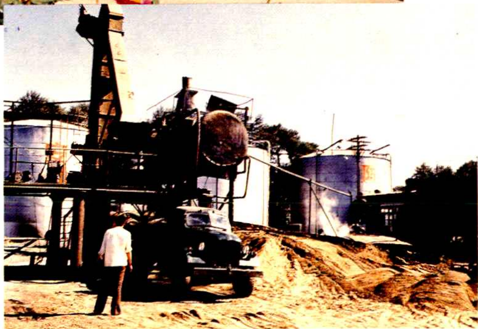
鸡西沥青储运站
