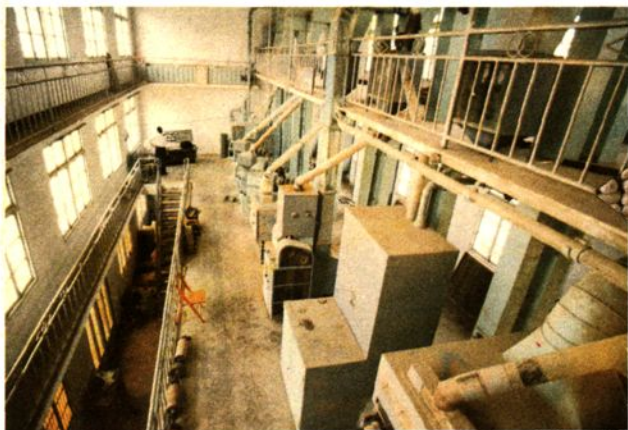
城关粮油加工厂大米车间及面粉车间一角
