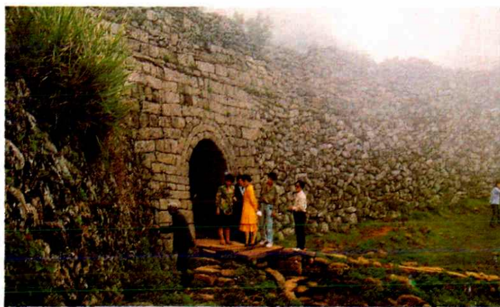
明代镇海 卫城墙遗址
