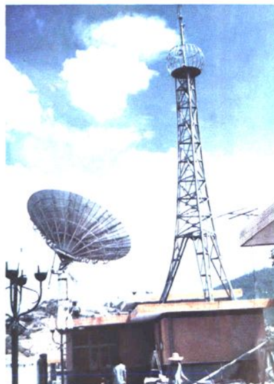
自建电视差转台
