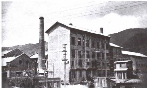
一期真空制盐厂房
