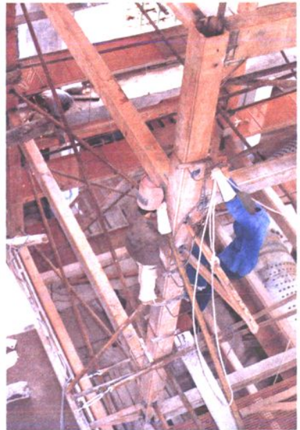
安装公司工人安装设备
