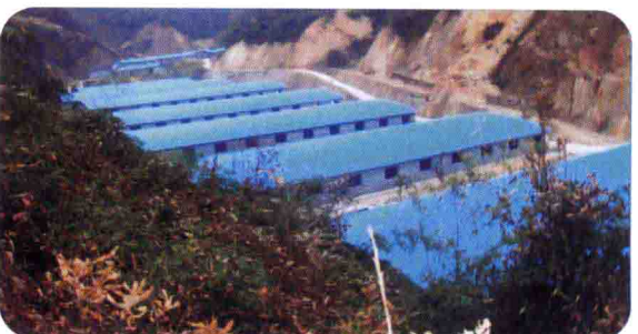
竹山县金源牧业科技有限公司猪场
