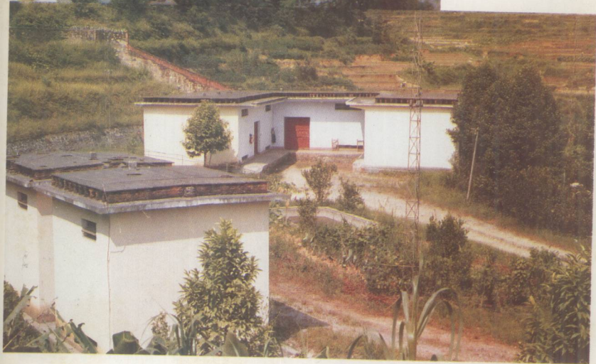
物资总公司珠洞八四仓库外貌
