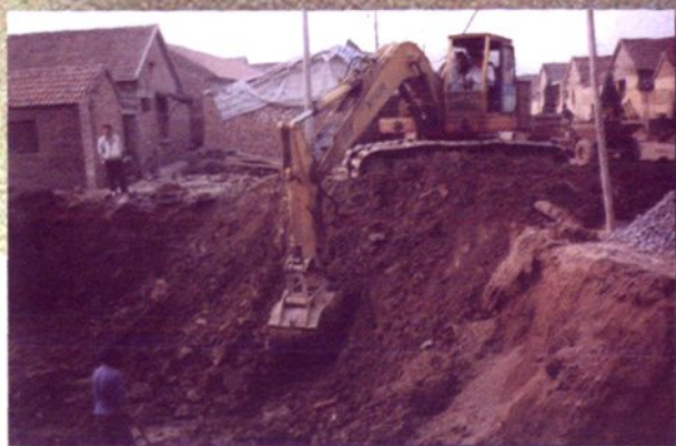
▲ 挖掘机取土开挖基塘
