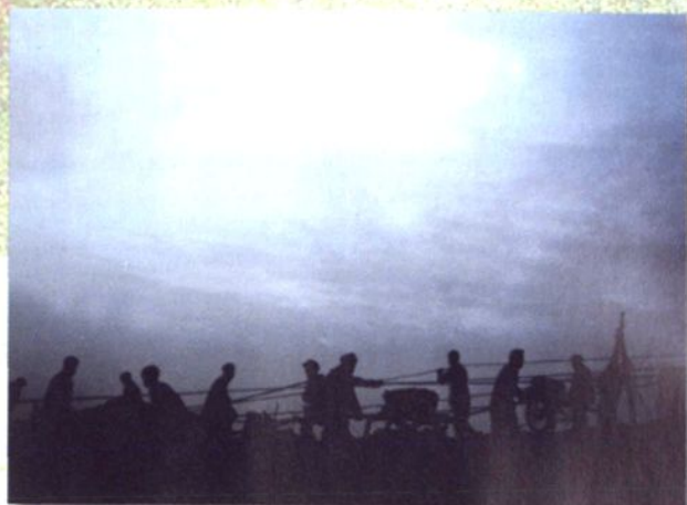
▲ 黑夜加班挖土方
