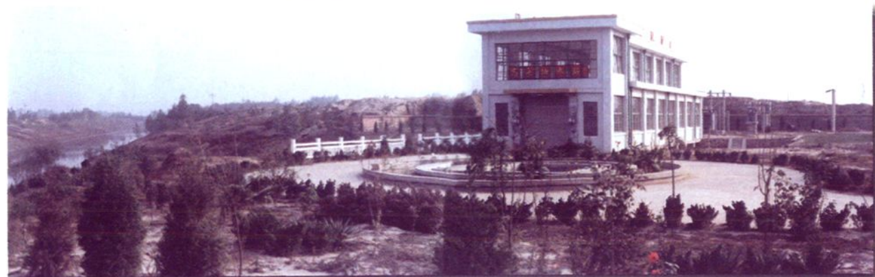
▼ 高集抽水站全景
