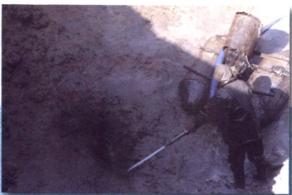
▲ 泥浆泵水冲挖河之二
