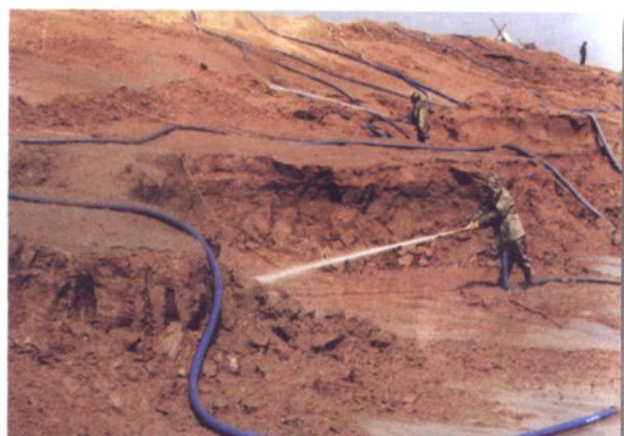
▲ 泥浆泵水冲挖河之一
