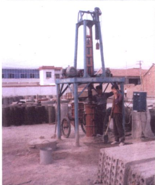
▶ 凌城镇水利站制管机
