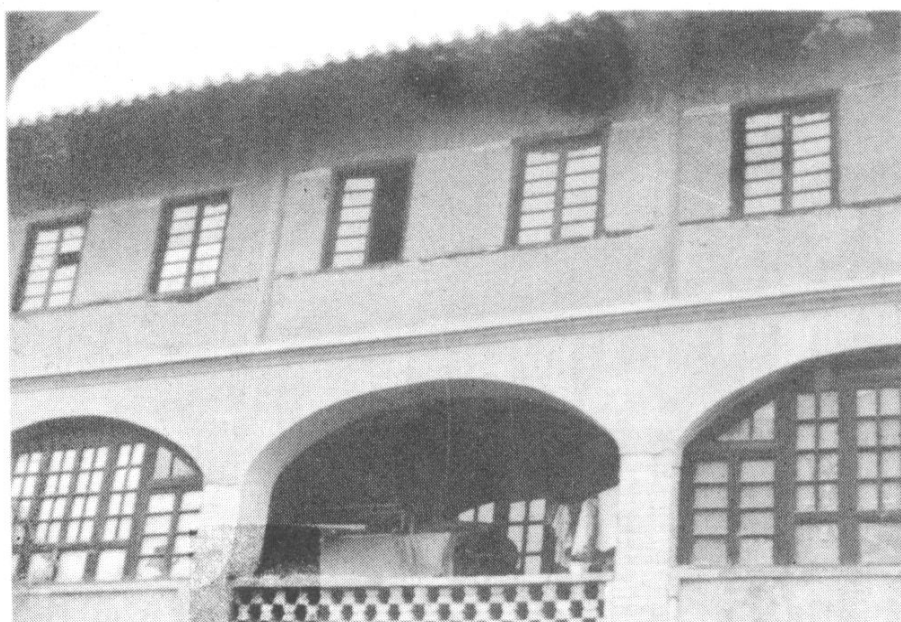
三楼是法院办公室
