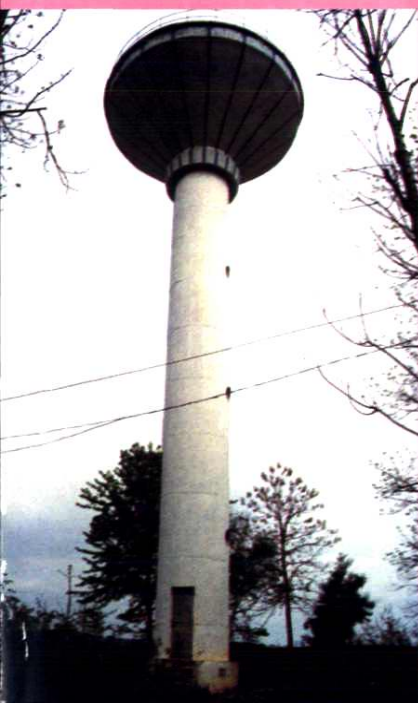
自来水厂水塔
