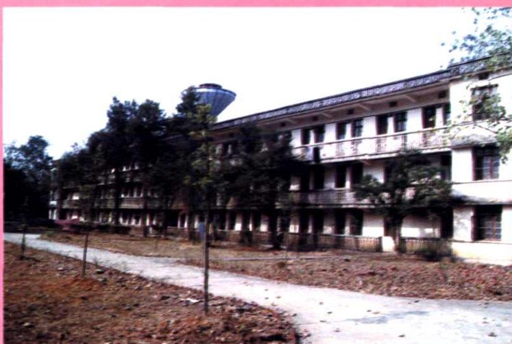
机关办公大楼
