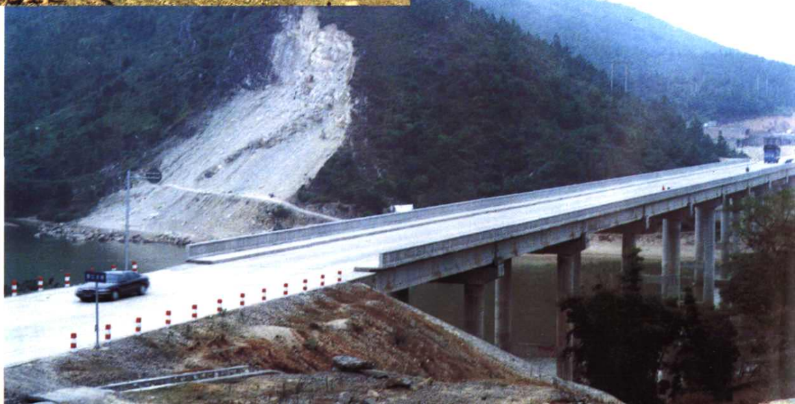
澄江大桥 (2000年建)
