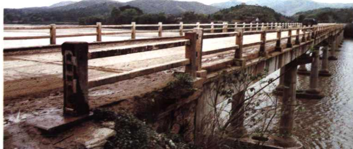
澄江大桥(1966年建)
