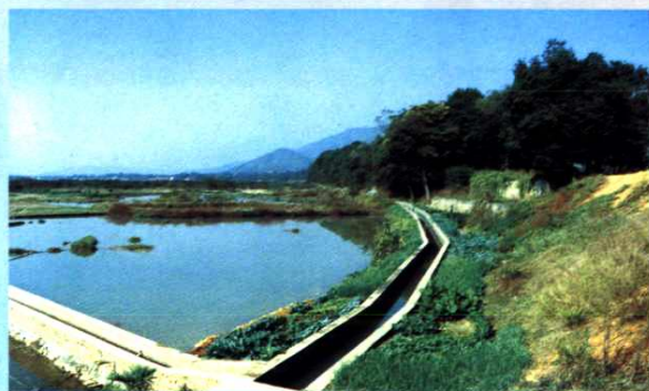
梓山河堤、水渠
