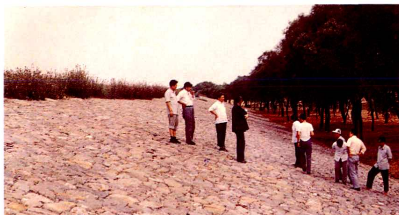
块石护坡工程竣工验收
