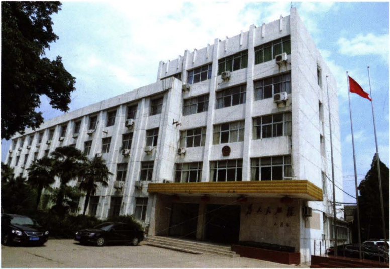
始建于1980 年春的县政府办 公大楼
