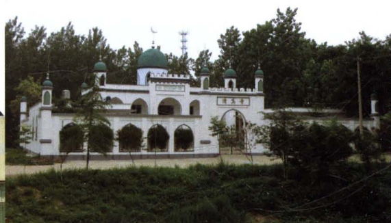
2002年开斋节时投入使用的 任桥镇桥东村清真寺
