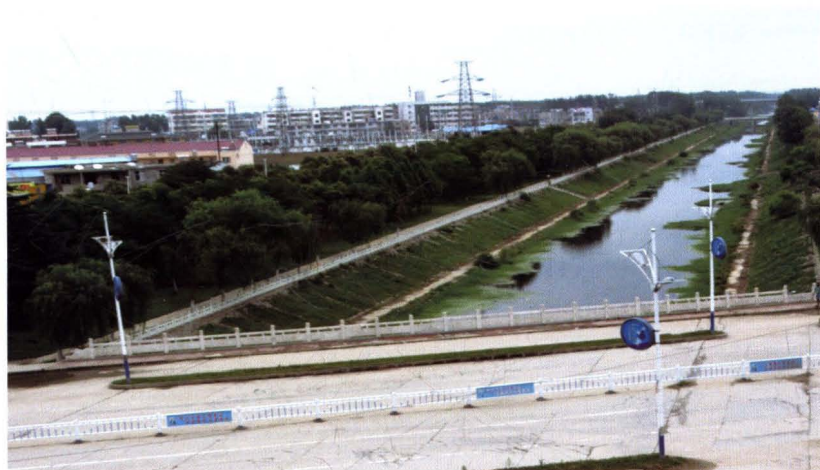
2002 年竣工的县城三八运河景观带
