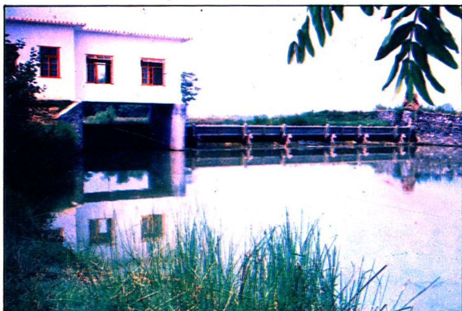
道华坝翻板闸
