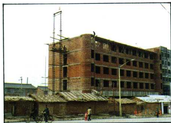
柏沟企业总公司在晋城市区修建晋城百汇公司
