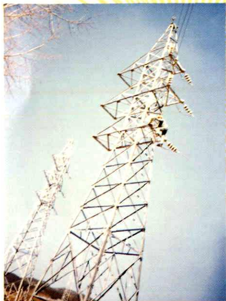
▲ 电力职工正在检修500千伏线路
