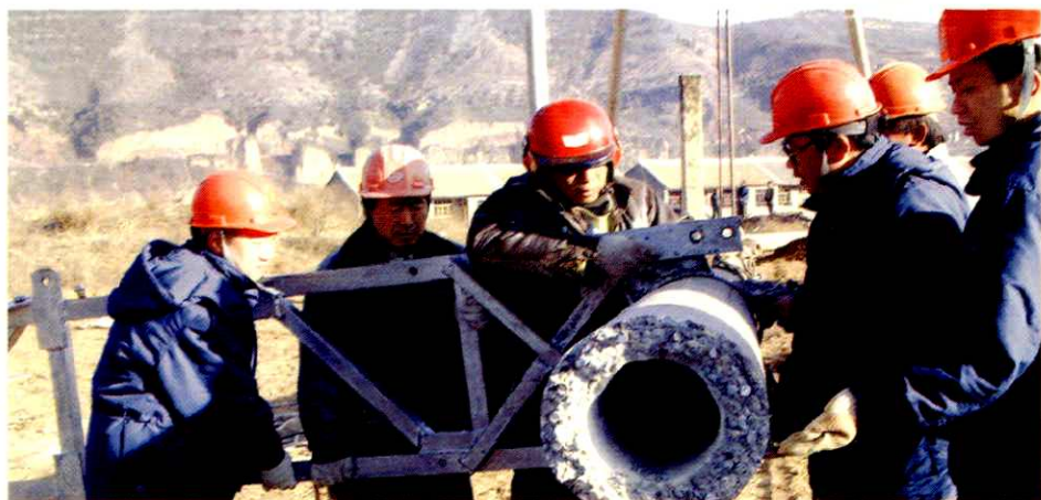
▲ 沁水供电支公司干部职工奋战在施工现场
