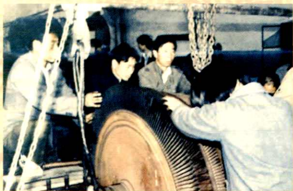
▲ 沁水发电厂3#汽轮机正在大修中
