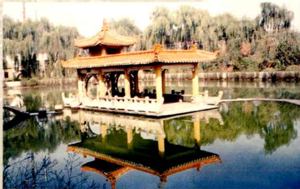
沁水发电厂环保花园式沉淀池
