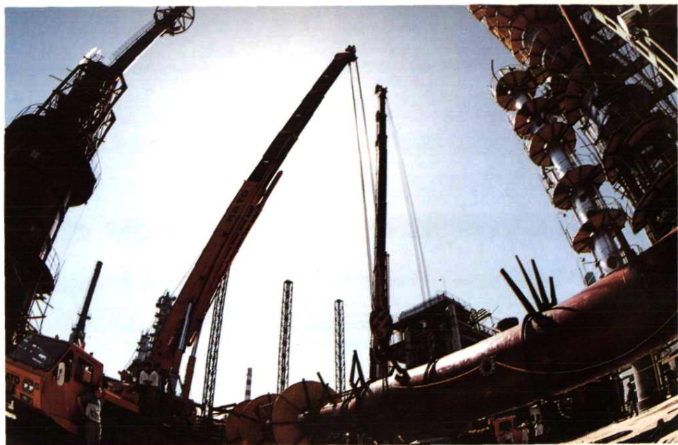
高 32 米的减粘分 馏塔吊装作业
