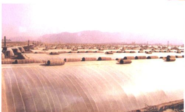
农业财源建设项目——日光温室▼
