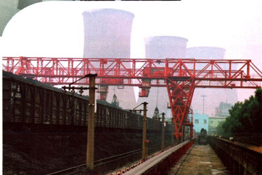
电厂铁路煤场
