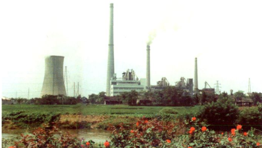
燃煤机组全貌
