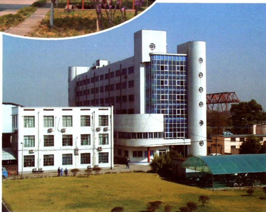
公司检修大楼
