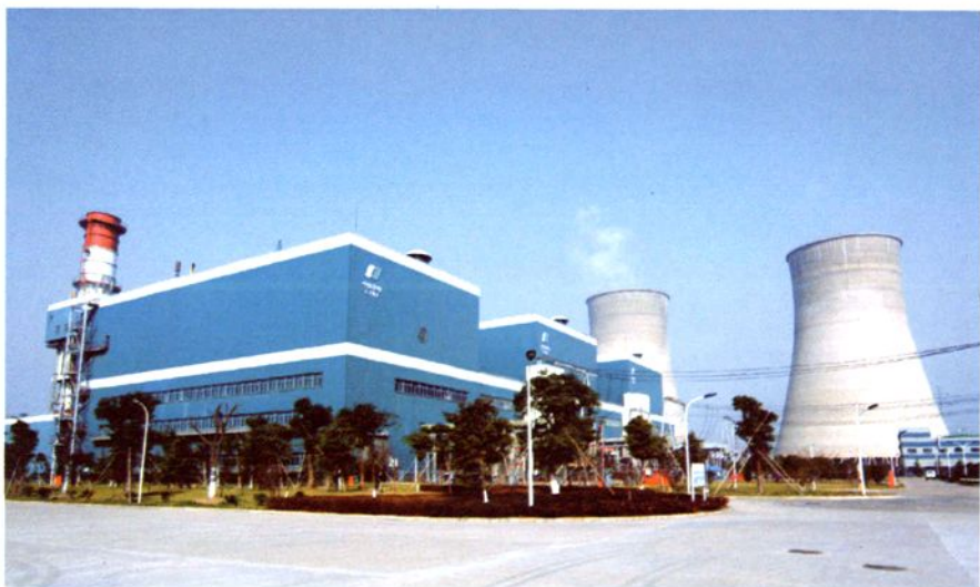
燃气机组外景
