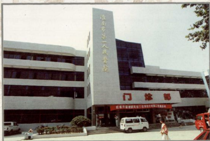
◀ 淮南市第一人民医院门诊大楼
