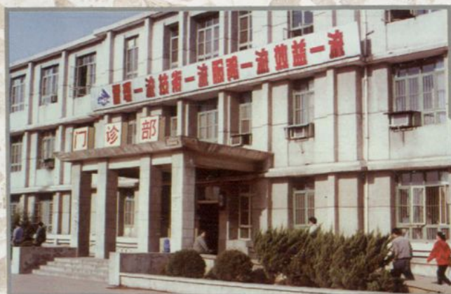
▼ 淮南矿务局第二矿工医院门诊部和医院全景
