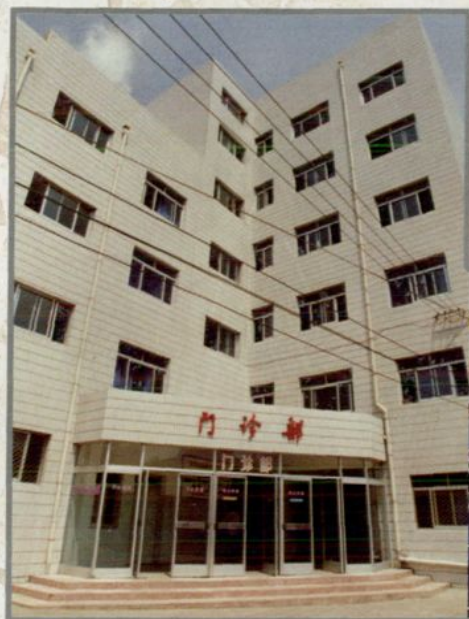
▲ 淮南市妇幼保健院门诊大楼
