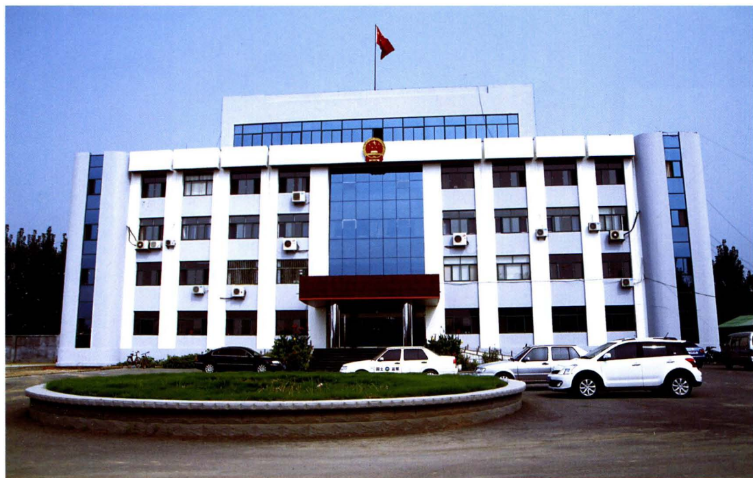
庞家镇政府办公大楼
