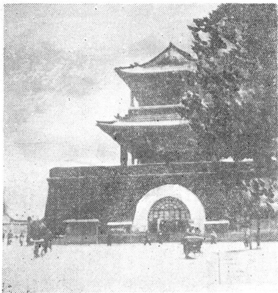
绥远城钟鼓楼（1959年春季拆除前摄）
