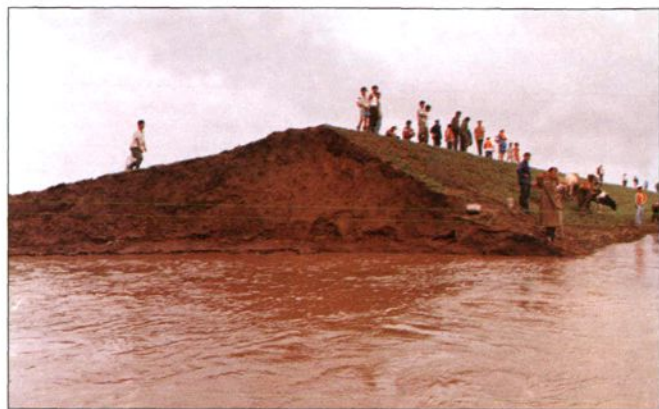
沈山线铁路被洪水冲毁
