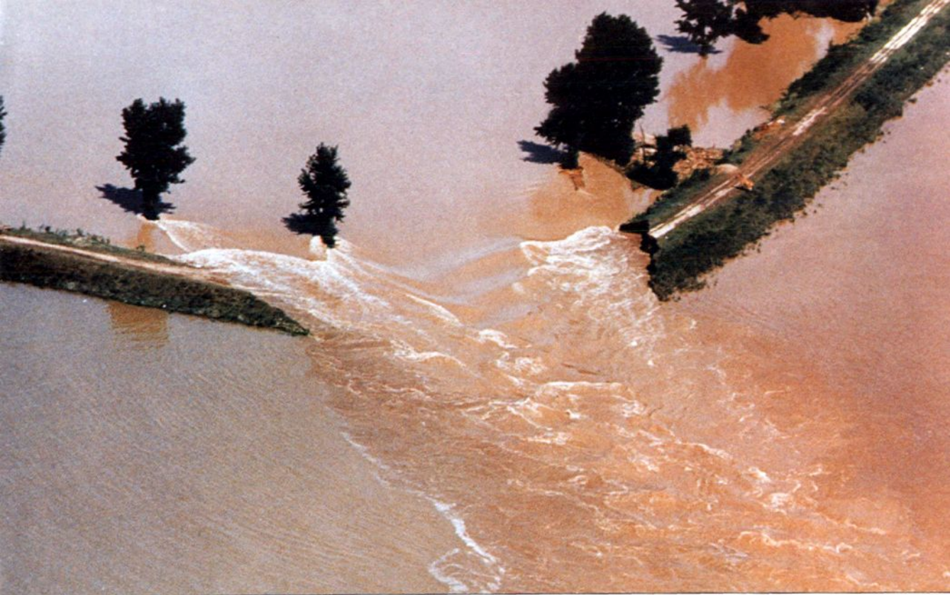
辽中县浑、蒲两河交汇处决口情景。
