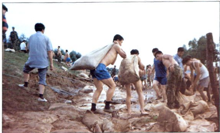
军民共同抢护辽中县鸟伯牛蒲河沙堤脱坡段
