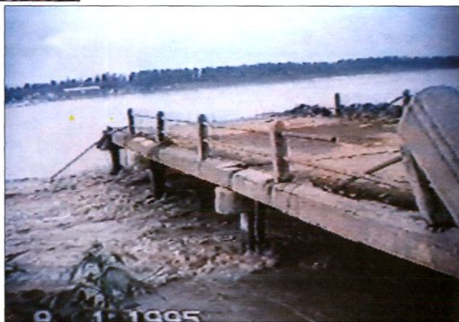
遭洪水破坏的浑南灌区渠首工程
