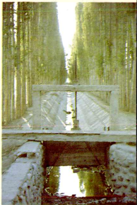
防渗渠道、闸门
