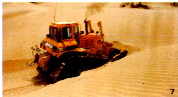
▲ 塔克拉玛干腹地施工
