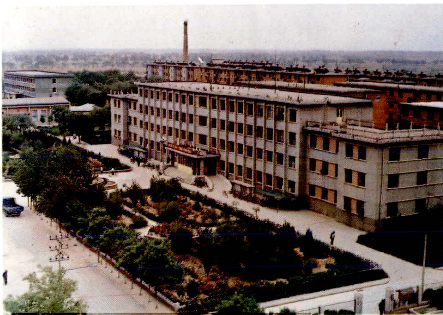
▲ 地调一处办公楼
