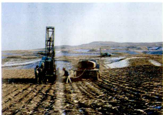
▲ 东北丘陵地区施工
