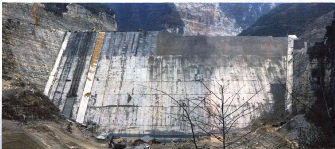
湖北西北口水电站大坝面板采用基础局发明的无轨滑模技术进行面板施工
