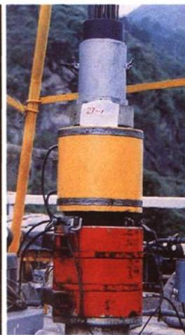
陕西石泉水电站6兆牛与8兆牛级预应力锚索工程(1995年)
