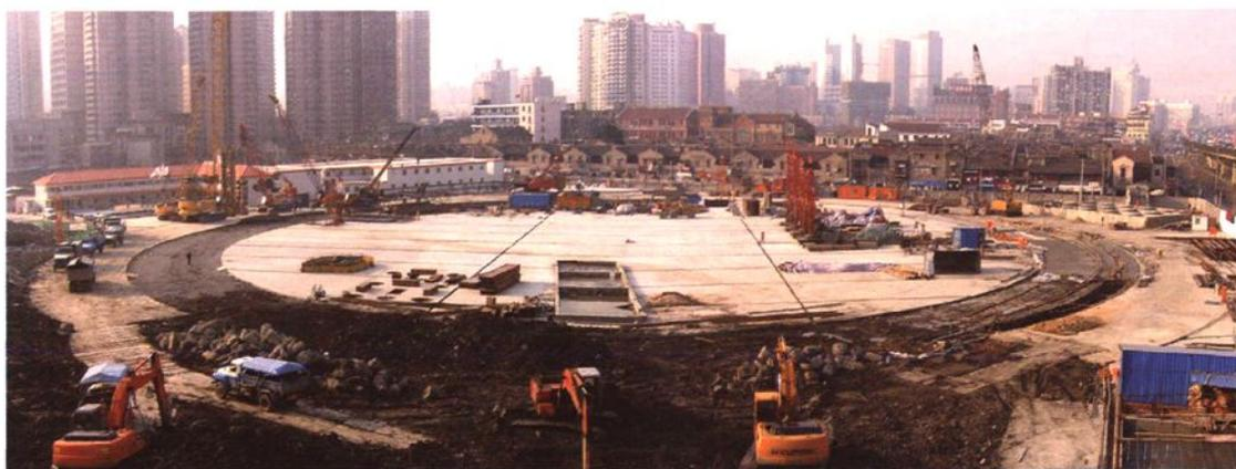
上海500千伏静安(世博)输变电工程地下连续墙工程施工(2006年)
