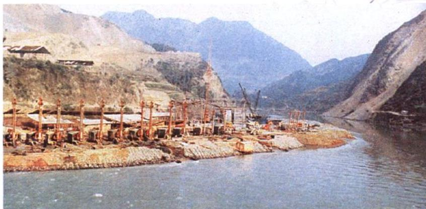
四川宝珠寺水电站左岸下游护坡防冲墙施工(1991~1992年)
