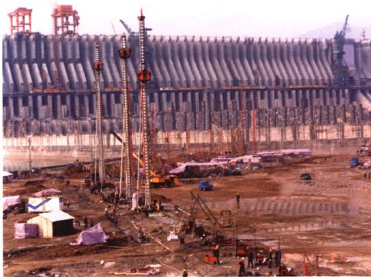
长江三峡三期围堰振动高喷防渗墙施工
