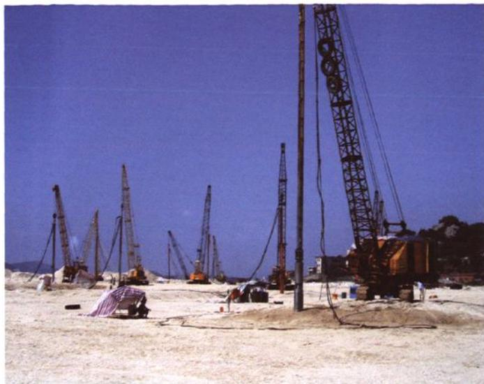
福建LNG围海造地振冲挤密工程
