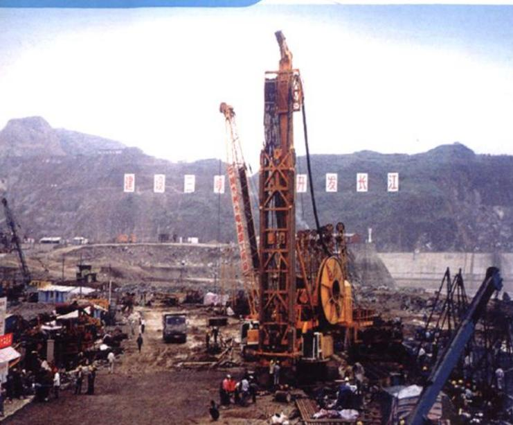
长江三峡水利枢纽二期上游围堰混凝土防渗墙工程(1996年)
