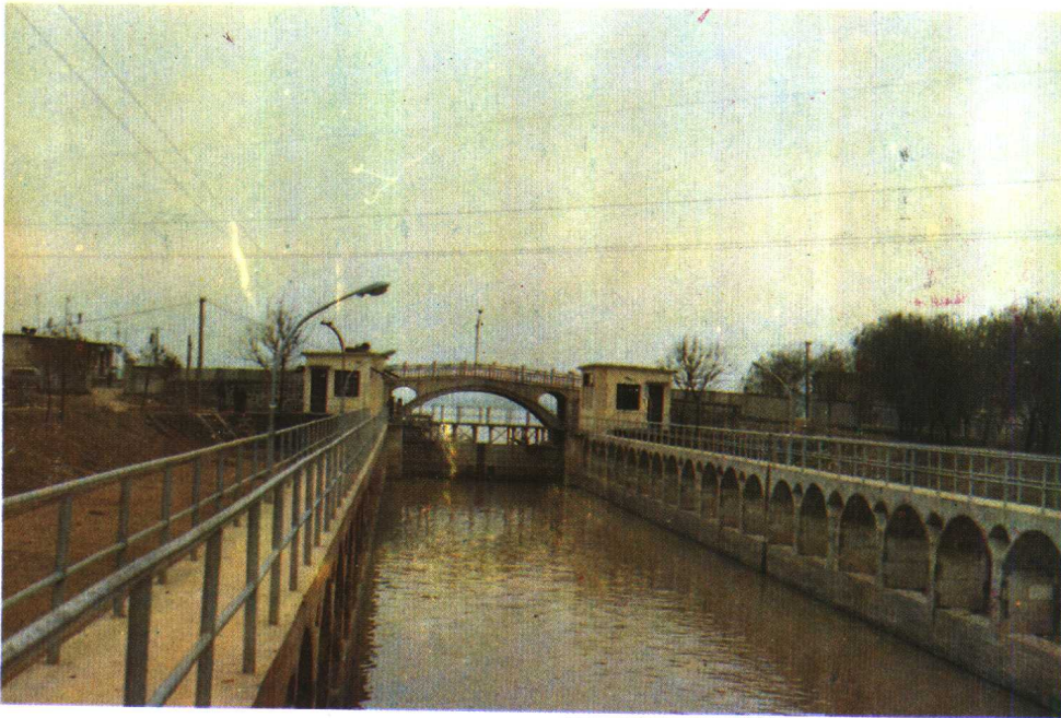
皖东水利枢纽工程女山湖大闸船闸
