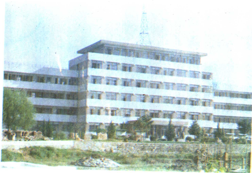
县委、县人民政府办公楼
