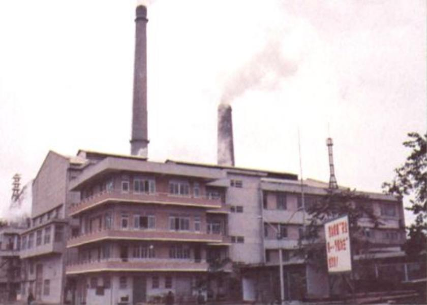
在原來配套糖酒生產的動力設備基礎上，經過1985、1987年兩期辦電工程後建成的發電廠，裝機容量5.5萬千瓦，日向電網輸出商品電100萬千瓦時。圖為該電廠外景。
