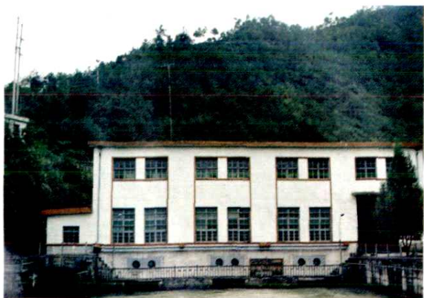
里石门水电站
