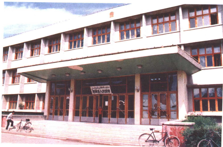
塔城市人民政府办公楼
