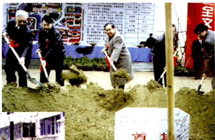
1997年4月18日建设部副部长李振东(中) 为东白鱼潭住宅小区工程奠基
