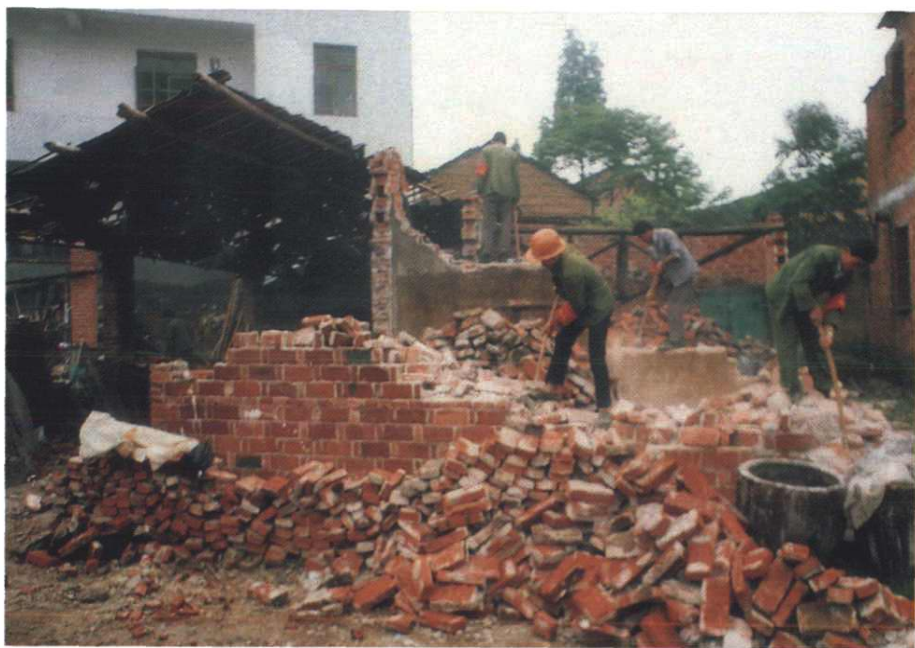
▲依法拆除违章建筑
