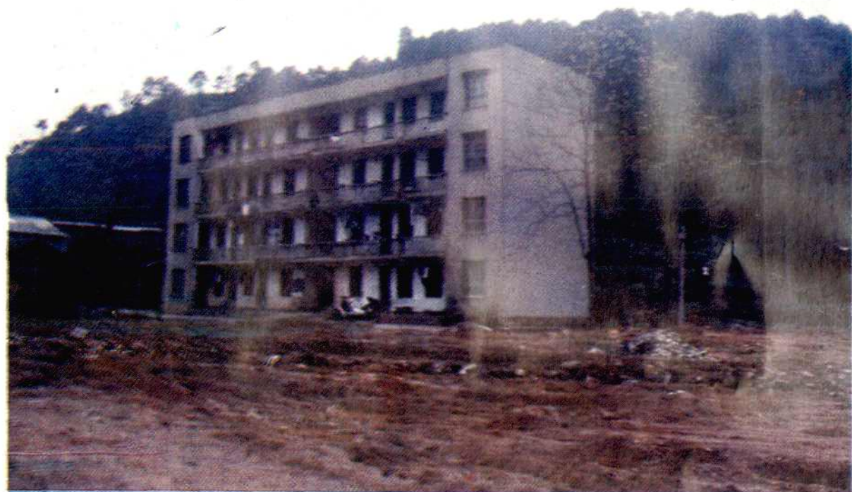
肖家坳环卫宿舍大楼
