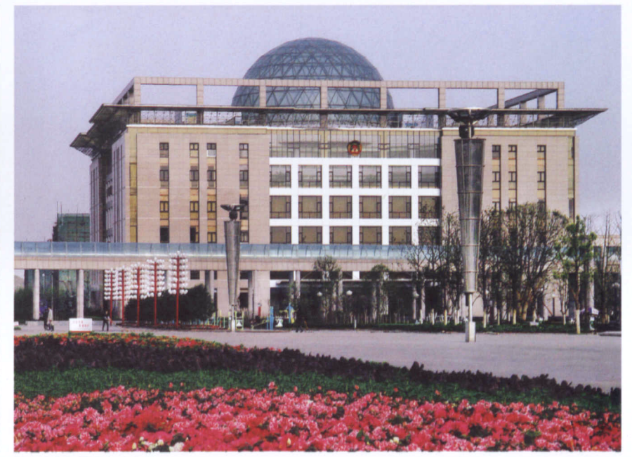
市政协金阳新区办公大楼
