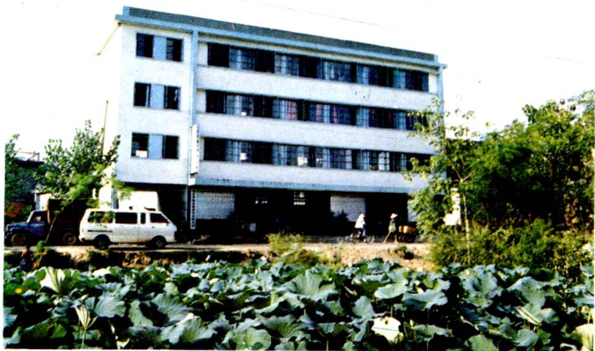
余江县粮食局安装公司办公大楼。
