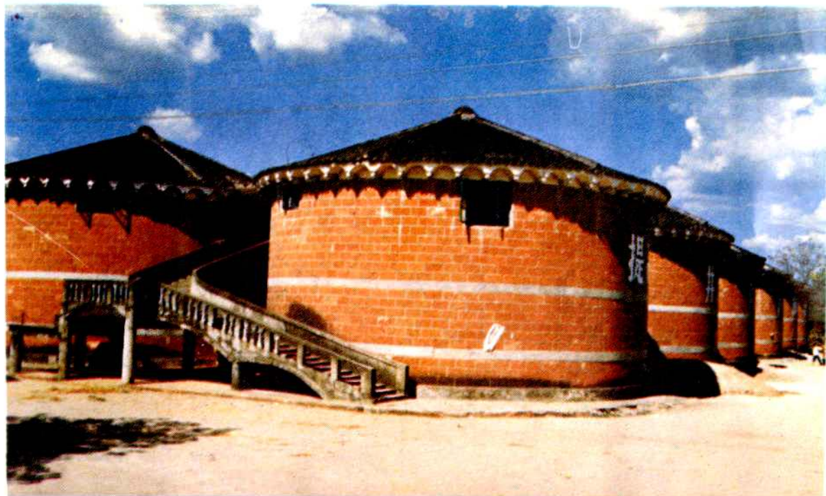
余江县粮食局大桥粮管所园筒仓库。
