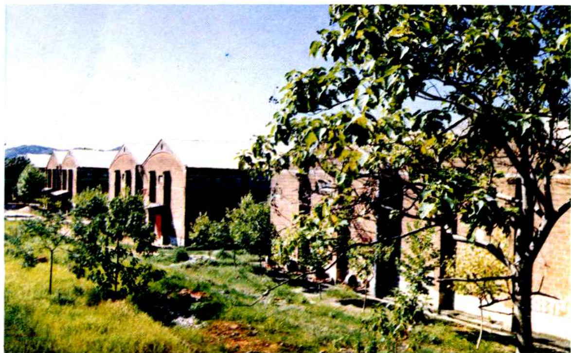
余江县大桥粮食储备库仓库。
