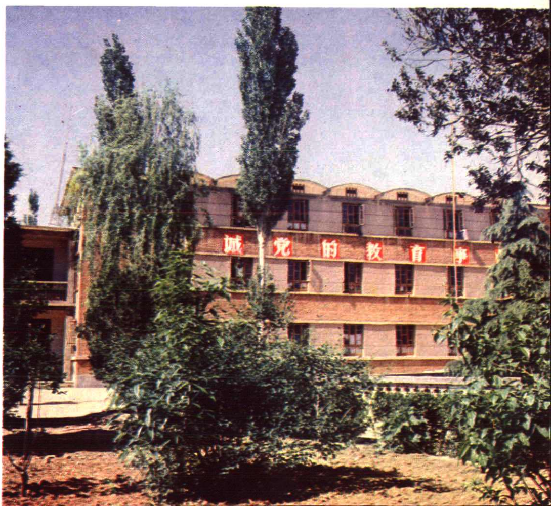
乾县第一中学宿舍办楼
