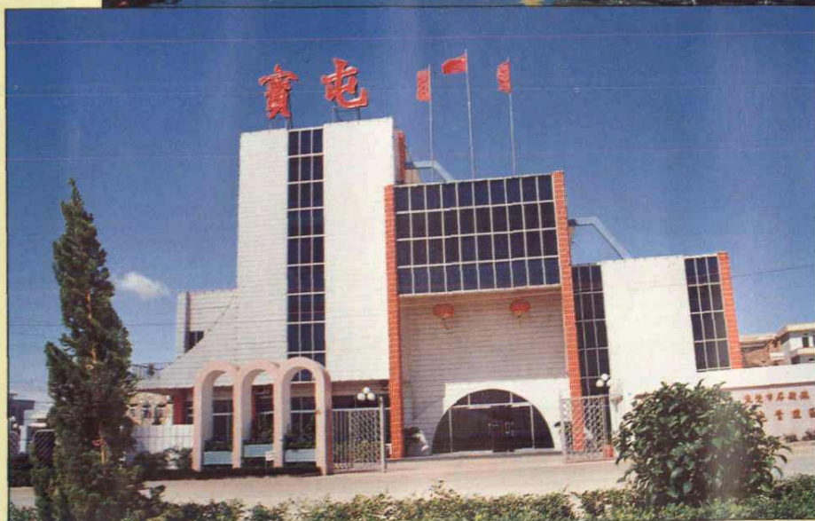
宝屯管理区办公楼
