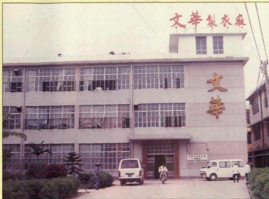
图为一九八五年兴建的第一间较大型的文華制衣厂。十年过去，请看下边林立的现代化厂房。
