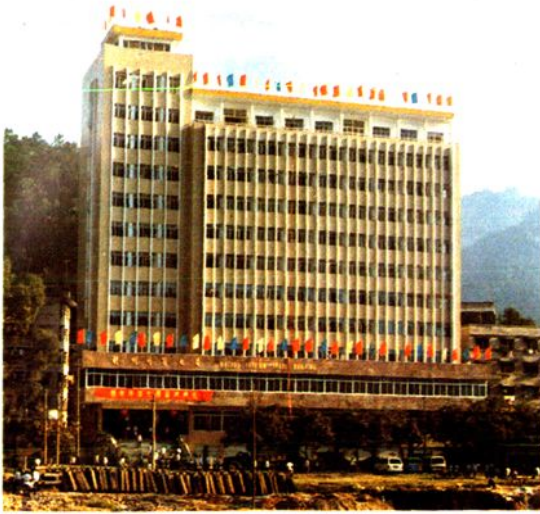
梧州口岸外贸大厦全景。
