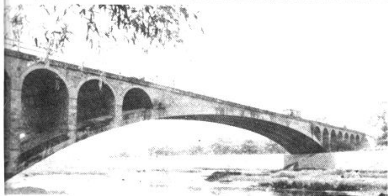
禹县北关双曲拱桥
