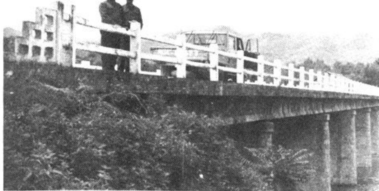
鲁山赵村工字梁微弯板桥
