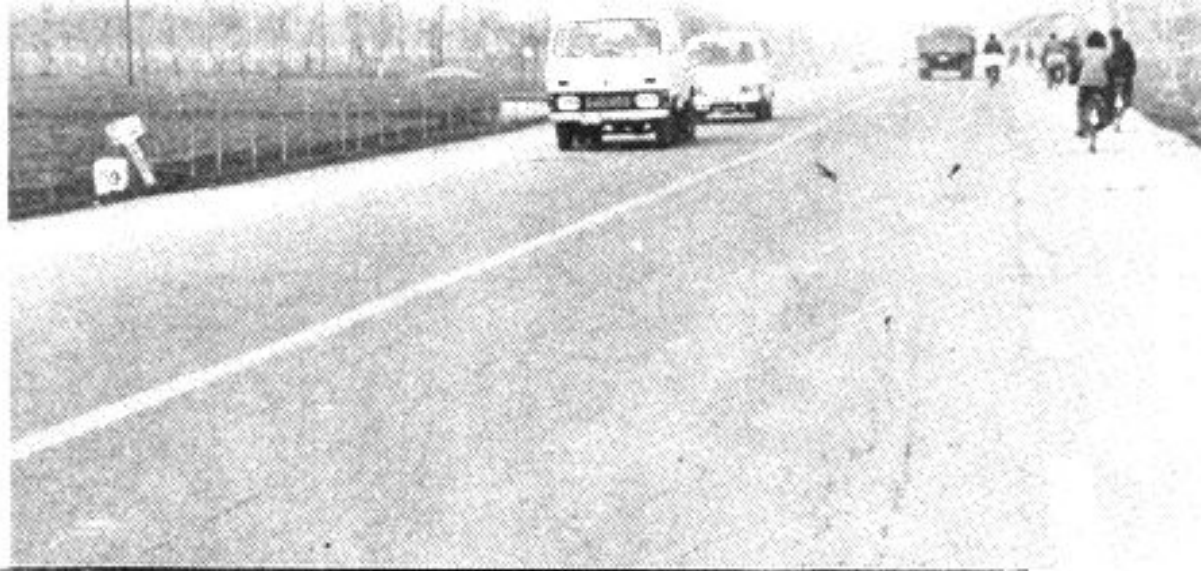
深公路 葛北渣 路面
