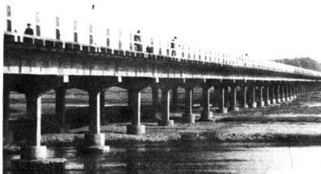
鲁山沙河T型梁桥
