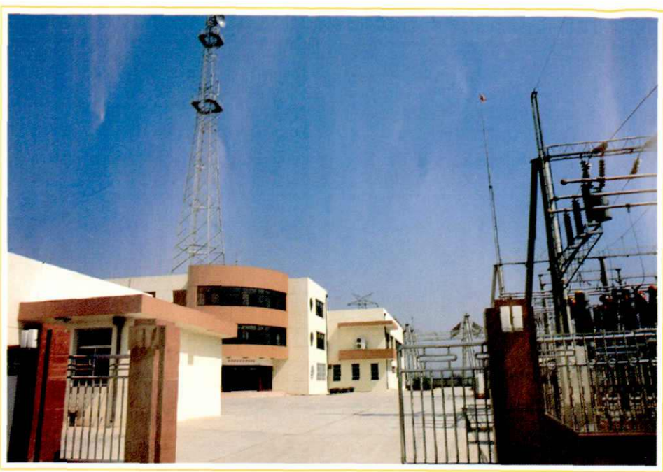
临晋 220 千伏变电站外景
