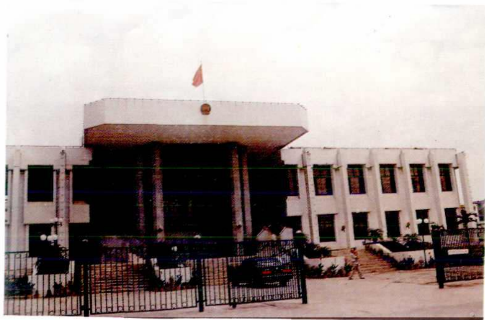
建成于 1989 年的厦门市中级人民法 院审判法庭（湖滨北路 115 号）。
