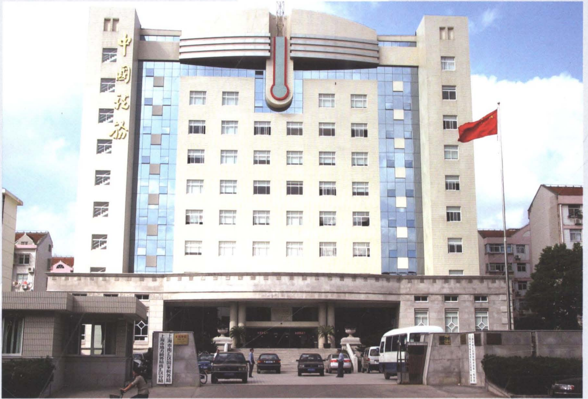
南汇区税务大楼（局机关、一所）
