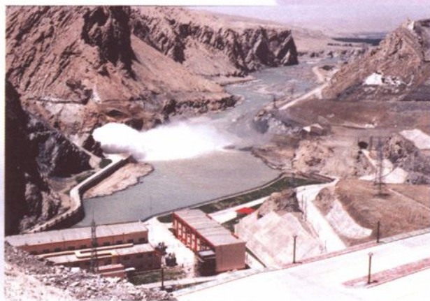
和田地区喀拉喀什河上的乌鲁瓦提水电站
