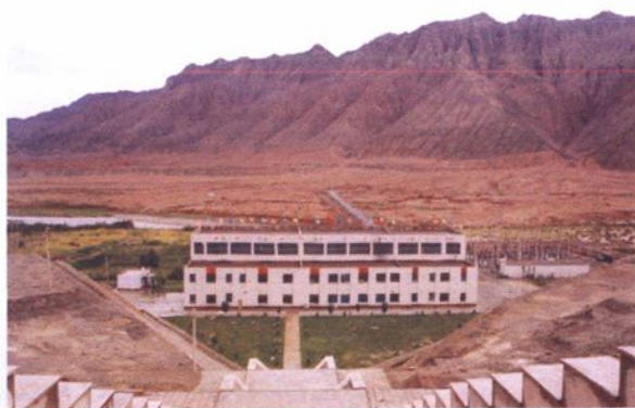
新疆第一座坝后式水电站—阿克苏地区渭干河上的克孜尔水电站
