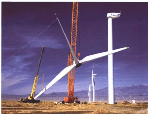
风力发电机组叶片吊装
