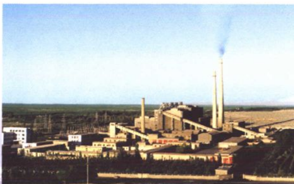
巴音郭楞州塔什店发电厂
