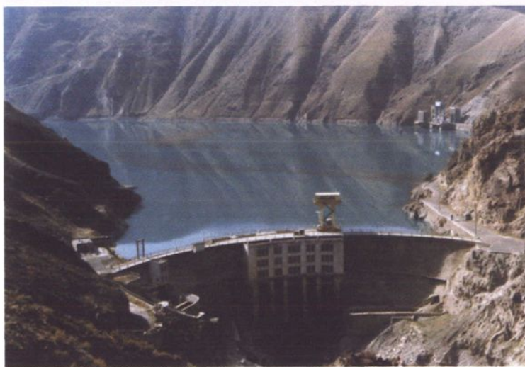
伊犁哈萨克自治州喀什河上的托海水电站
