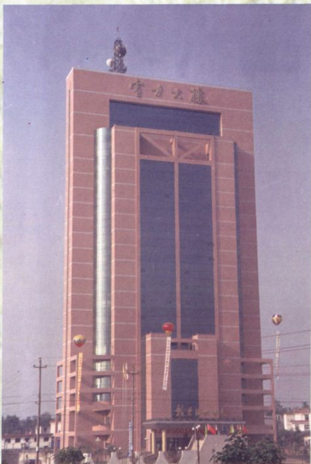
赣东北供电局电力大楼
