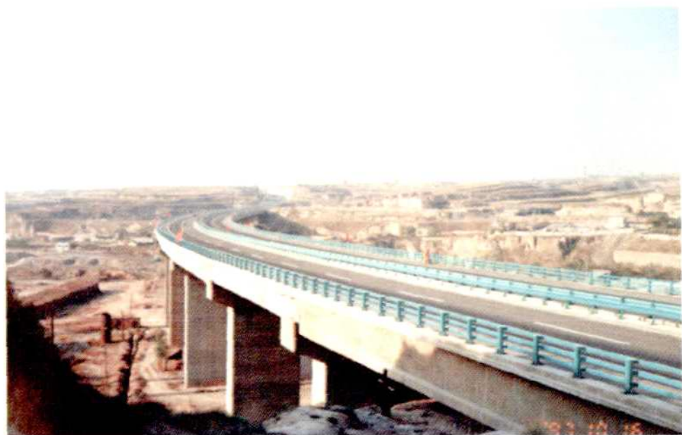
东山过境高速公路跨越涧河段
