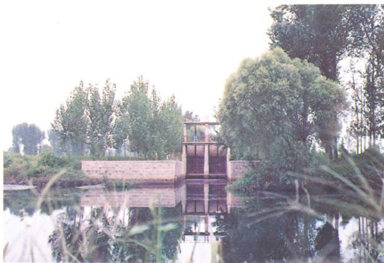
14. 引黄过清节制闸
