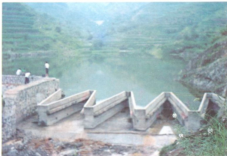
13. 园子台水库“迷宫堰”式溢洪道
