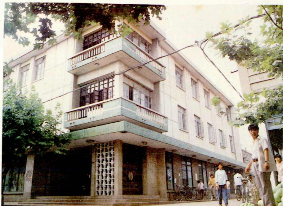
秦南供销社综合营业楼
